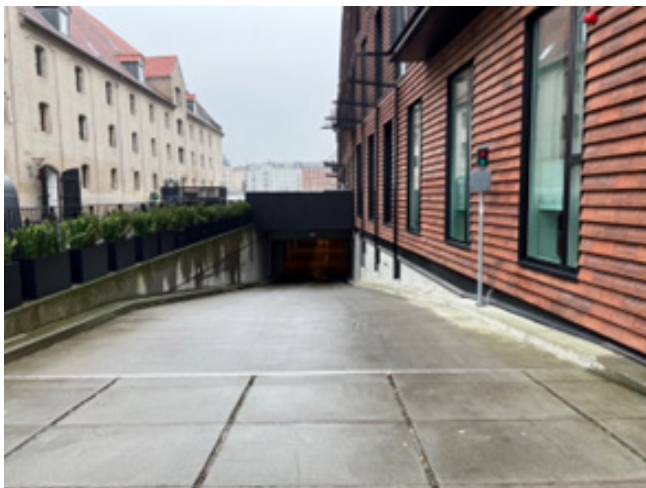
Parkeringskælder under bygning. Foto: Charlotte Amalie Frejlev
